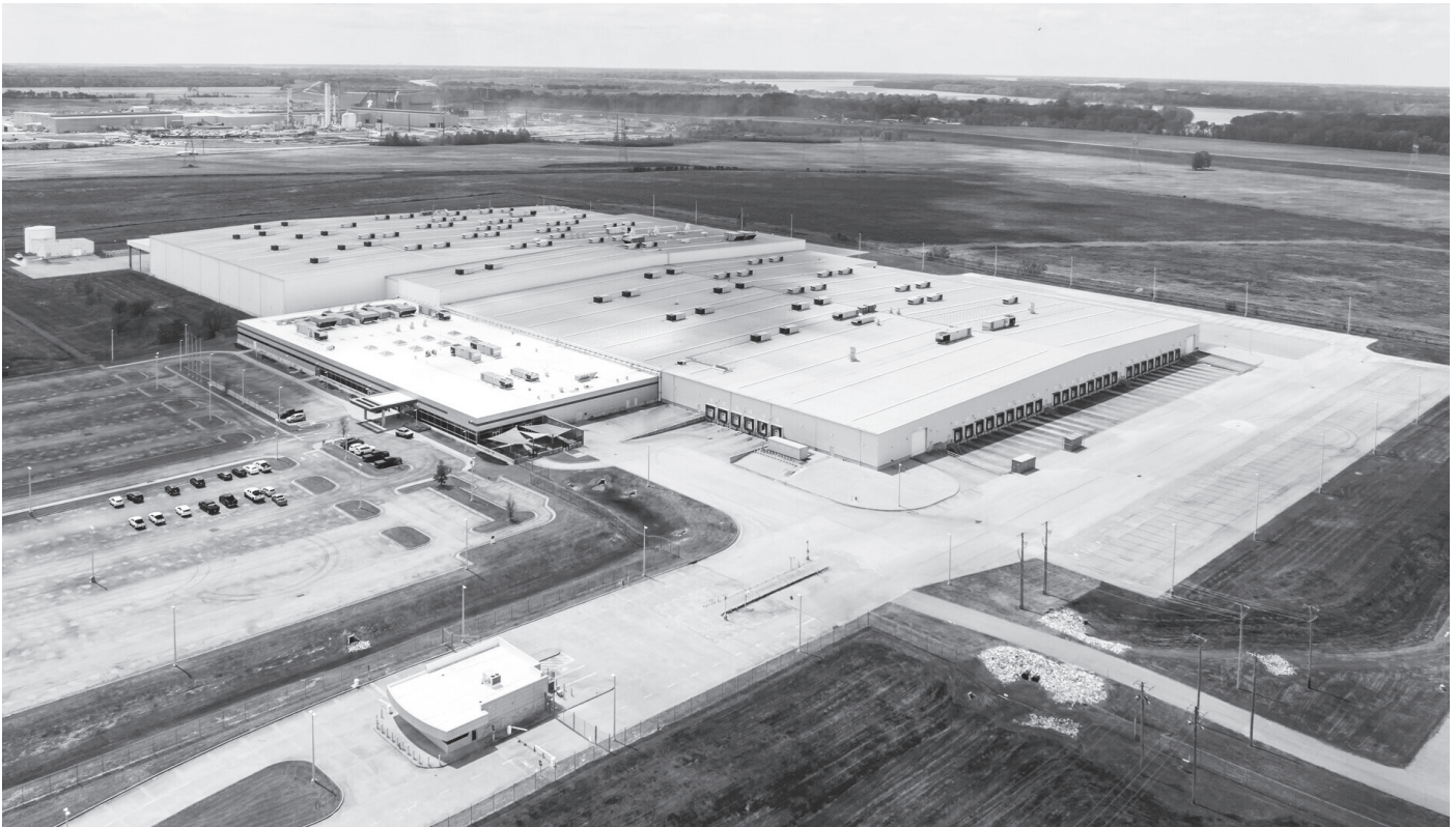
Erste Ausbaustufe des KI-Rechenzentrum Colossus von xAI (Elon Musk) in Memphis, Tennessee, USA
